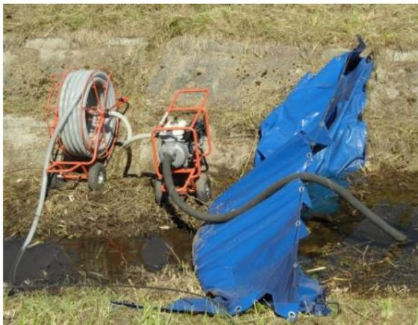
**Технологический регламент очистки от наносов труднодоступных элементов закрытой мелиоративной сети с использованием разработанных РУП «Институт мелиорации» средств малой механизации**
